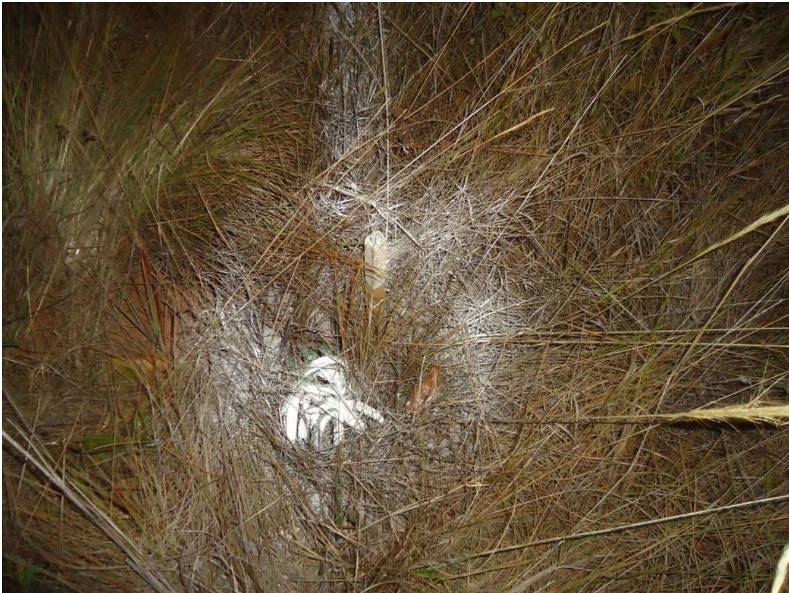
Marcação com cal no local da estaca na posição
