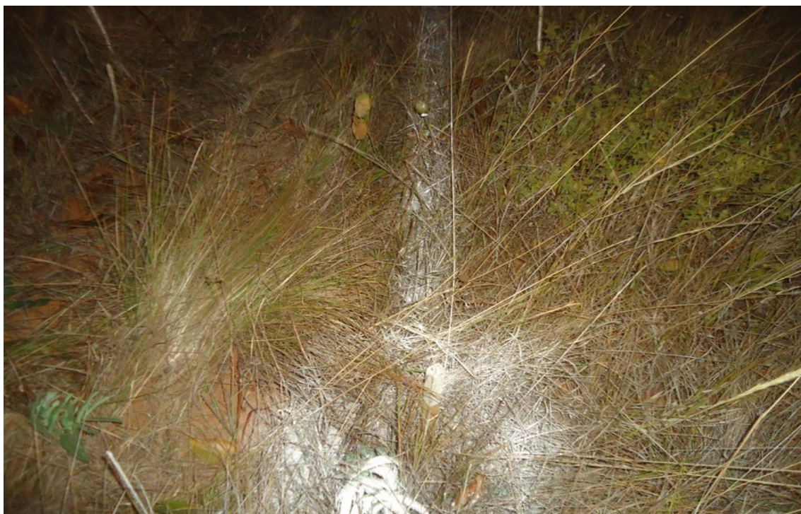
Marcação com cal no prolongamento do eixo da lançadora
